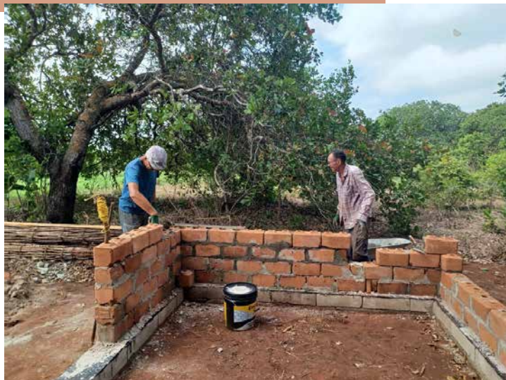
Hier wird von Volontären ein Hühnerhaus gebaut.
